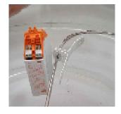
3.- Realizar las conexiones eléctricas en el cebador, tanto del cable de alimentación como del casquillo del halógeno. Colocar el halógeno y por último colocaremos de
